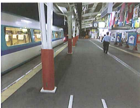
①支柱への木製カバー
