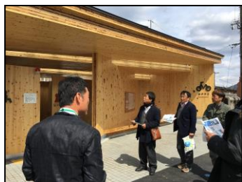
CLTの公衆トイレ
