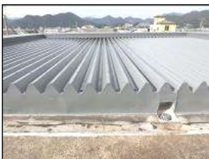
屋上修繕後の様子
