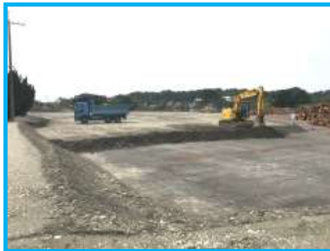
下貯木場海側の基礎盛土工事
