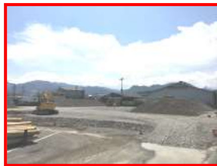
下貯木場山側の試験盛土工事
