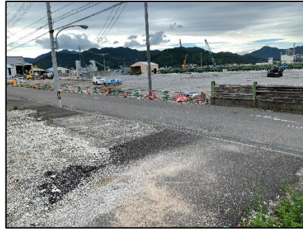
迂回路工事に伴い木柵の撤去
