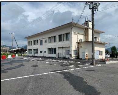
会館裏の利用範囲拡大工事
