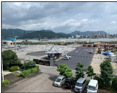
上貯木場の一体利用工事
