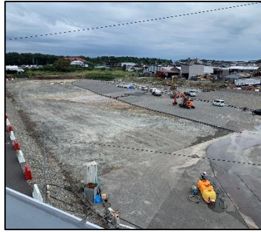
工事の進捗状況
