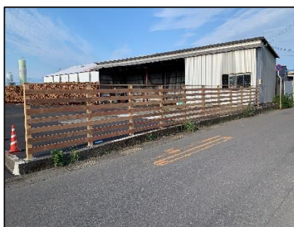
完成した板塀
