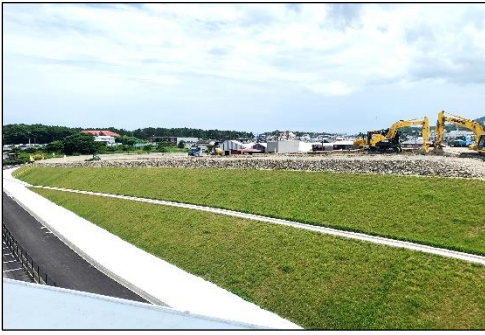
新宮・紀宝道路盛土工事 (木材会館屋上より撮影)
