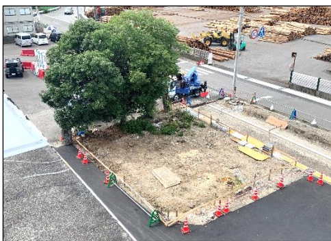
木霊塔施設の撤去工事
